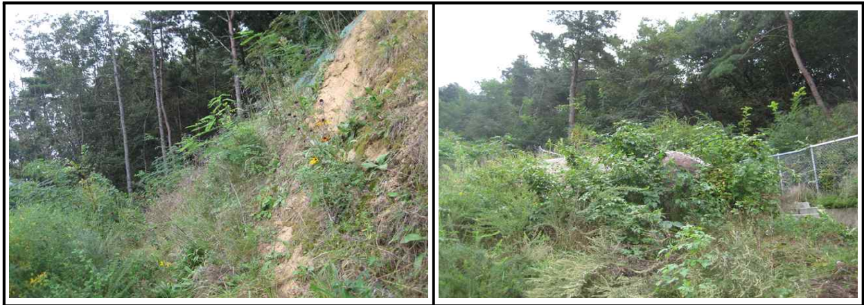
【그림 1.3.1】 상부자연사면 전경
