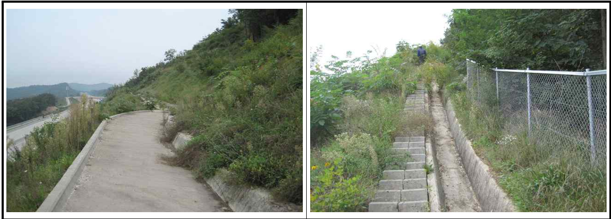
【그림 1.3.3】 배수시설 전경
